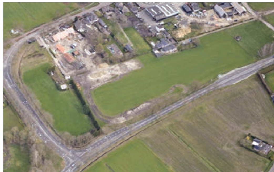
Oblique luchtfoto locatie Smits van Oyenlaan
